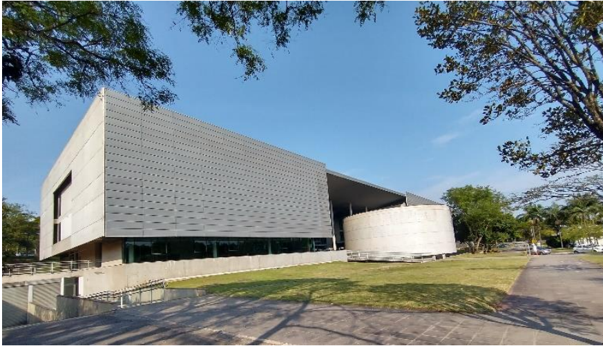
Figura 13 – Edifício da Biblioteca Brasileira Guita e José Mindlin
